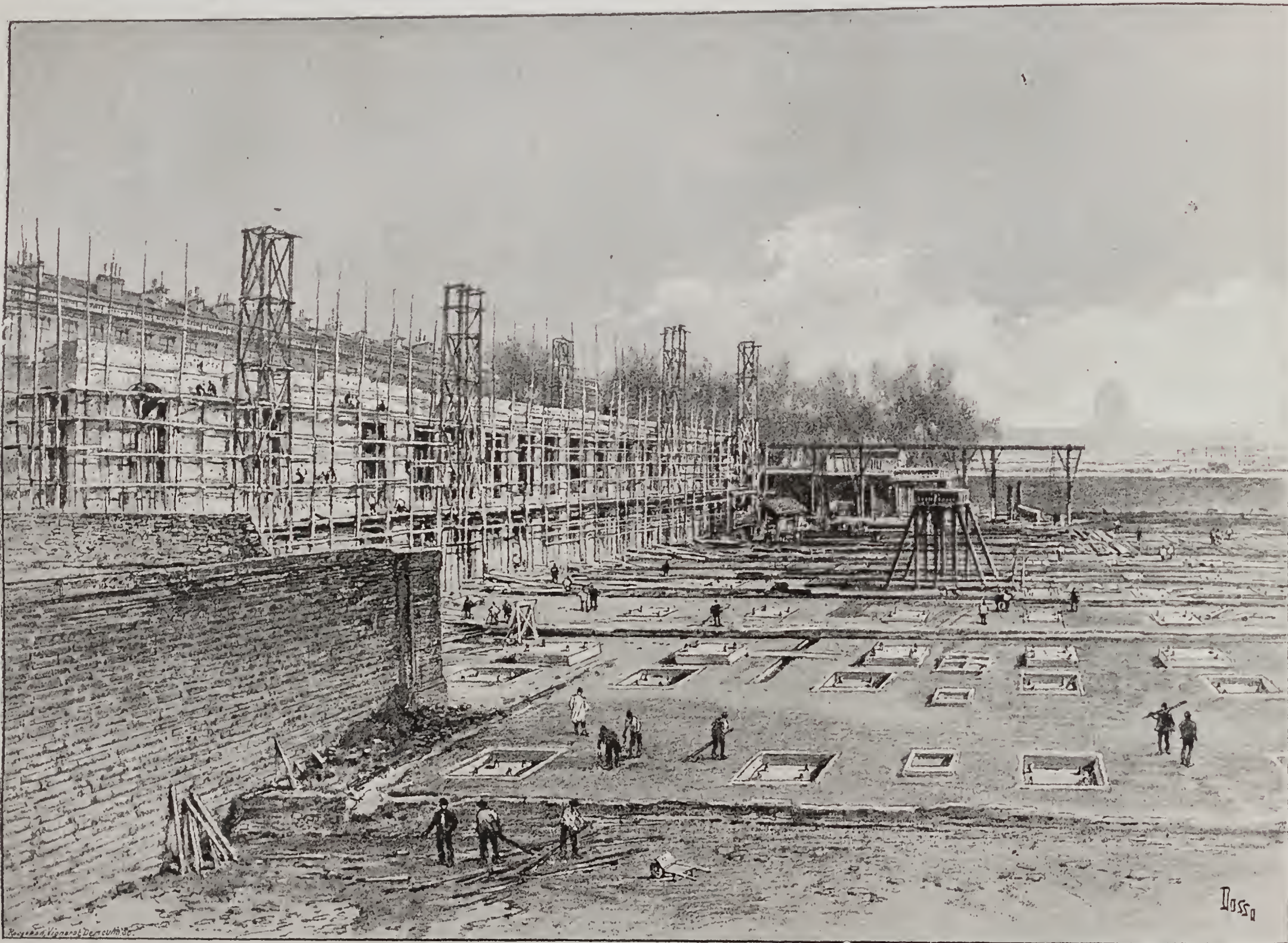
LA GARE DES INVALIDES. — Aspect de la construction et des voies, avant l'établissement du tablier métallique.
